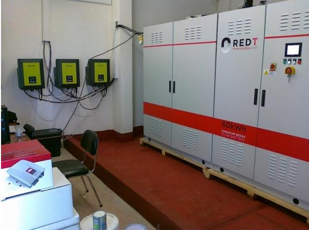
Fig. 4 Projecto PVCROPS – Building Integrated PV – sistema completo com inversores e bateria alimentando um edifício da Herdade da Mitra
