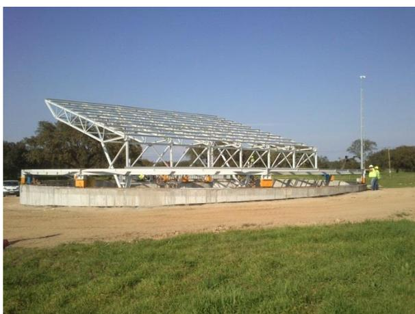
**Fig. 2- Plataforma de Ensaio do banco de ensaio de concentradores solares (em construção, conclusão prevista para Maio de 2015)**
