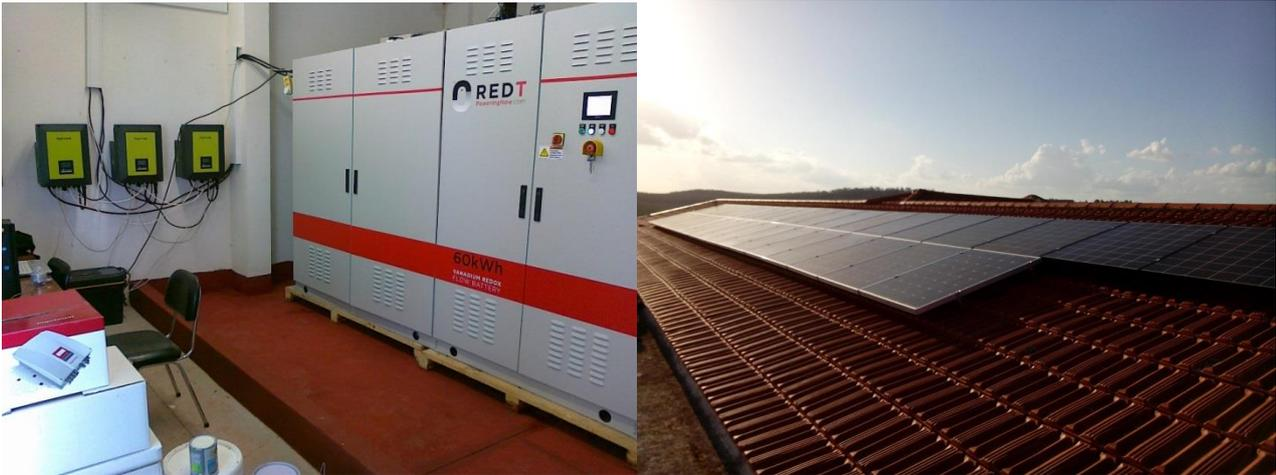
**Fig. 4 Projecto PVCROPS – Building Integrated PV – sistema completo: PV+ inversores e bateria alimentando um edifício da Herdade da Mitra**
